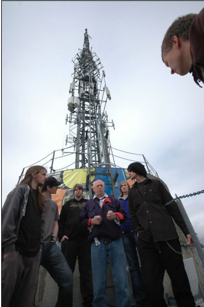
Stålmasta med mobiltelefonantennener. Linselusa Terje prøver og å få bli med.
